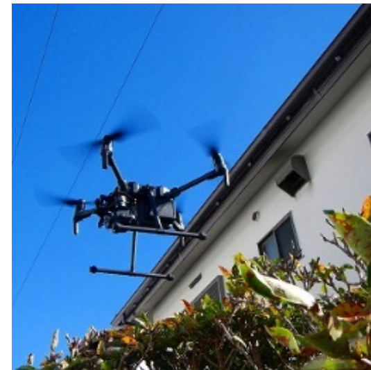
UAVsを活用した外壁点検業務
